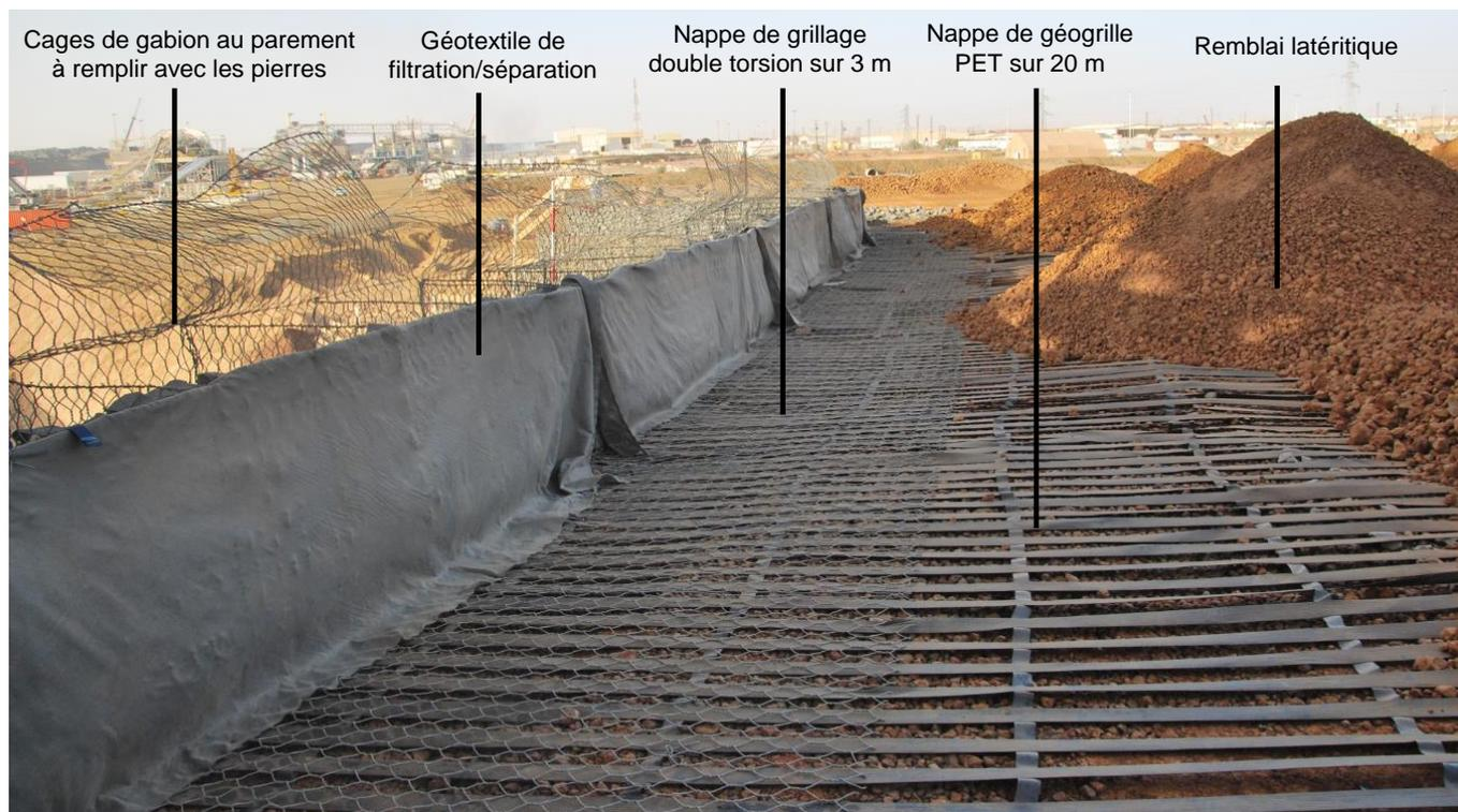
Figure 5. Mise en tension d'une géogrille avant la mise en place du remblai
