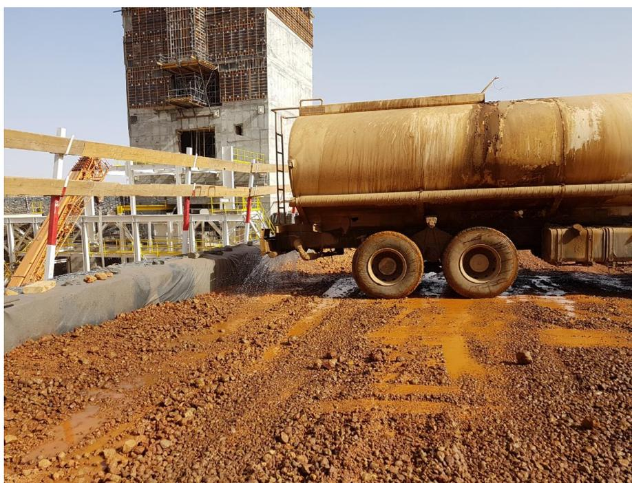
Figure 6. Arrosage du remblai technique avant compactage
