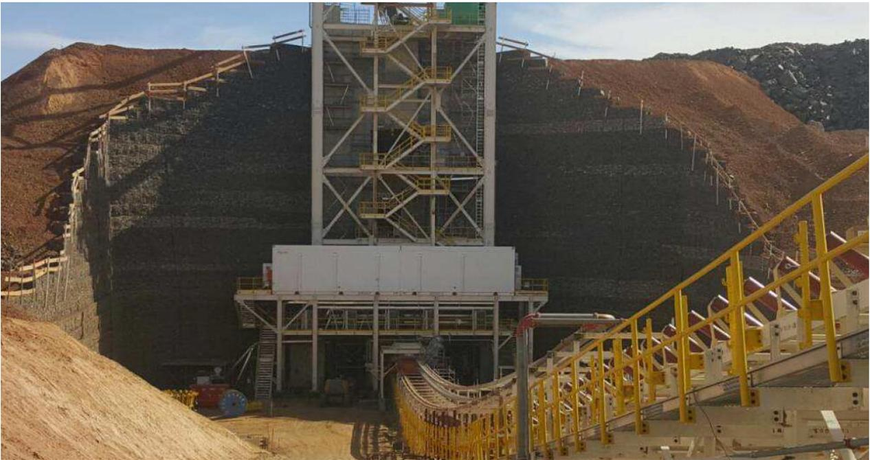
Figure 7. Vue d'ensemble des ailes du mur de soutènement du concasseur primaire en fin de chantier
